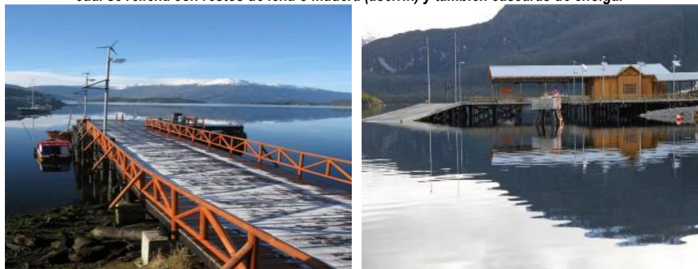
Figura 12. Muelle fiscal de Puerto Edén Rampa (izquierda), Rampa y Refugio DOP-MOP (derecha), atracadero de uso particular (inferior), construido a través de un cierre perimetral en su parte delantera, la cual se rellena con restos de leña o madera (aserrín) y también cascaras de cholga.
